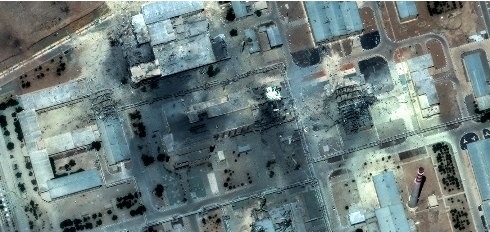
Dieses Satellitenbild, bereitgestellt von Maxar Technologies und aufgenommen am 22. Juni 2025, zeigt die Schäden durch die US-Schläge an der Urananreicherungsanlage von Isfahan im Zentrum Irans. (Bildnachweis: Satellitenbild ©2025 Maxar Technologies/AFP)
